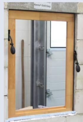
Einbau mit Hilfe von Montagekissen
