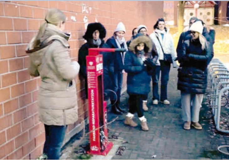
Begutachtung der Fahrrad-Reparatur- und Servicestation (FRS)
