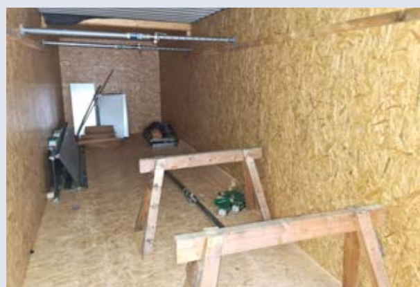
Wand- und Deckenausbau
