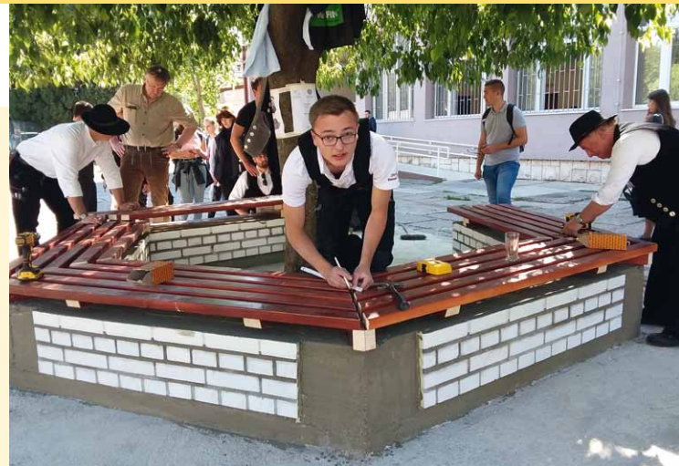
Zimmerer bei der Arbeit
