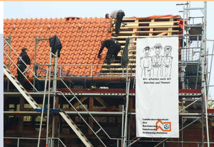
Die Schüler der LBS-Dach auf dem Dach des Refektoriums
