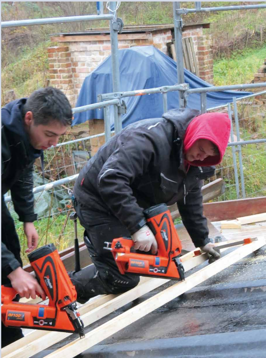
Einsatz der Impulsgeräte der Firma Paslode
