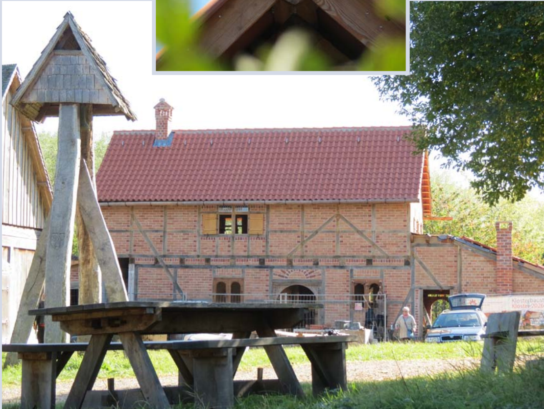
Das fast fertige Refektorium mit einem interessanten Detail
