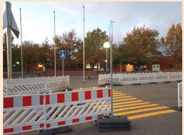
Fußübergang auf dem Schulhof
