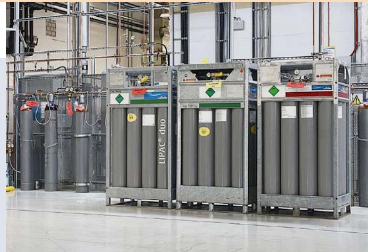
Früher benötigte Kendrion ein ganzes Arsenal an Gas-Flaschenbündeln für die Produktion. Jetzt wird der Stickstoff selbst erzeugt. (Bild: Atlas Copco)
