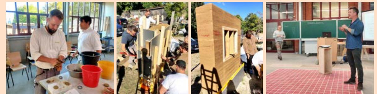
Die ästhetische und architektonische Ausdruckskraft der Stampflehmbauteile ist neben dem sehr guten raumklimatischen Effekt, ein weiterer Grund für die Wiederbelebung dieser alten Bauweise. Die unterschiedlich erdfarbige Struktur des Materials bleibt sichtbar, und die Wand kann im noch plastischen Zustand an der Oberfläche bearbeitet werden. Der Übergang von handwerklicher zu künstlerischer Ausführung wird fließend.
