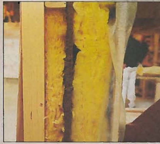
ETTER BOKEN: Slik skal det se ut etter etterisolering.
