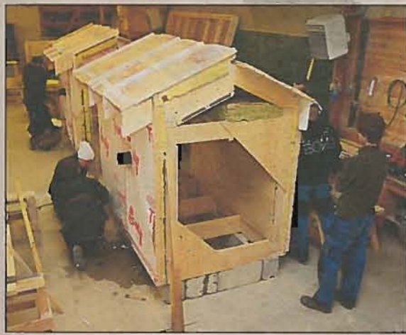
NY ISOLASJON: Modellen er etterisolert for å nå dagens standard.
